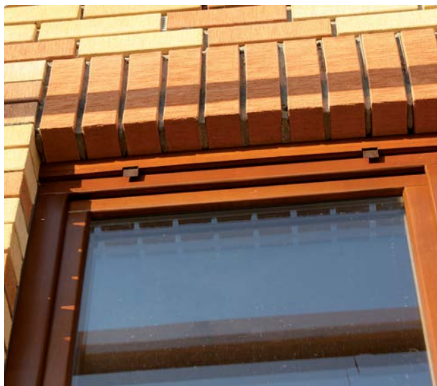
Внешний вид кладки с использованием перемычек BRICKO
