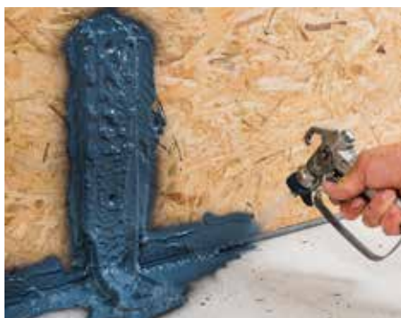
Воздухонепроницаемая изоляция крепежных элементов,
