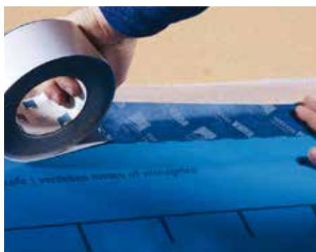
Соединение с ветровлагозащитной мембраной.
