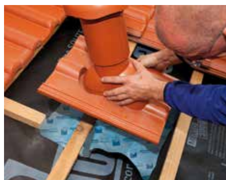
ROFLEX exto для простого соединения с вентиляционной трубой.
