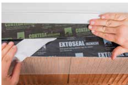
Установите окно, снимите защитную пленку и равномерно приклейте ленту по всему периметру оконной рамы.
