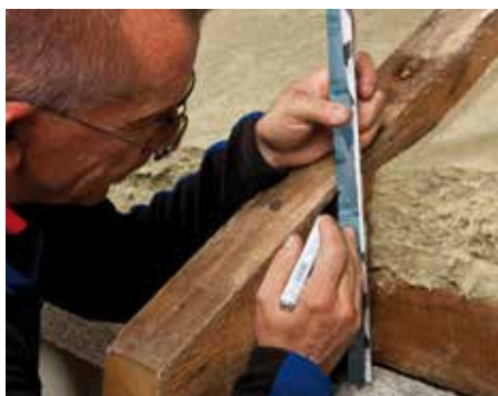
Отметьте длину до верхнего края.
