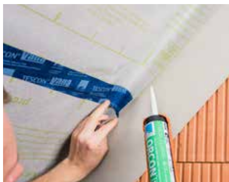
Для соединения с прилегающими основаниями пароизоляции внутри,
