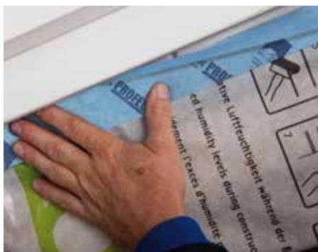
Изоляция соединений с мансардными окнами внутри,
