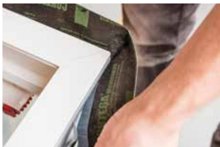
Сформируйте деформационные петли на углах (длина: 1,5 x ширина шва).
