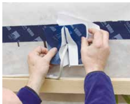
KAFLEX post, если кабель уже выведен и использование других манжет уже невозможно.
