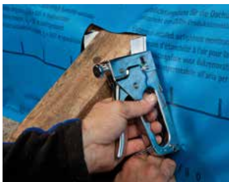
Закрепите мембрану на профиле TESCOFIX скобами.
