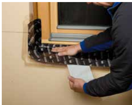
Использование в качестве изоляции под отливом.
