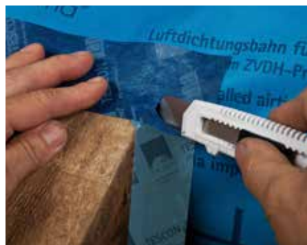
Приклейте мембрану на стропило с помощью клейкой ленты TESCO VANA.
