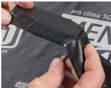
TESCON NAIDECK при вбивании гвоздей заполняет отверстие.
