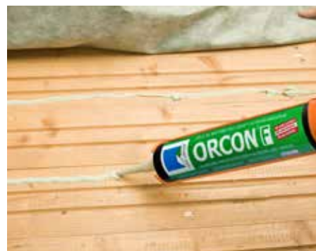
...пароизоляции при изоляции по стропилам,
