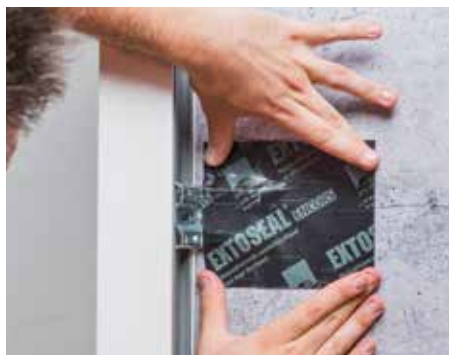
Водоотводящая изоляция элементов крепления.
