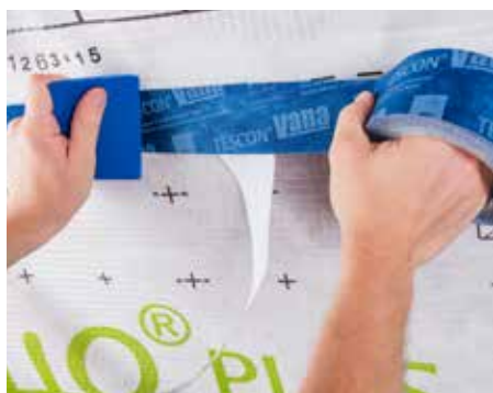
Склеивание нахлестов пароизоляционных мембран внутри,
