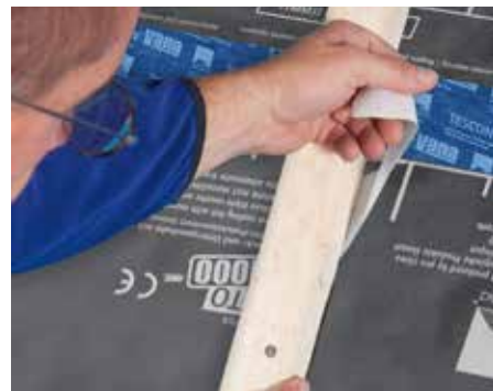
Плавню удалите разделительную пленку.
