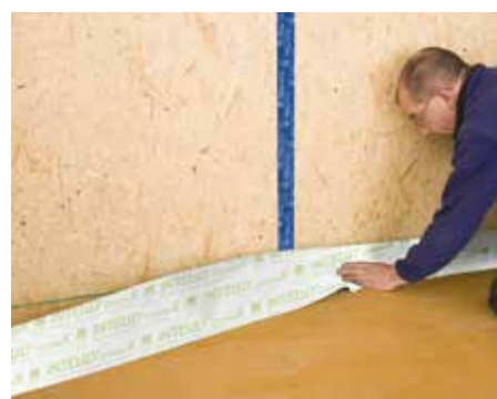
...например, с помощью INTELLO connex.
