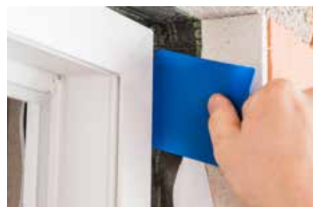
Хорошо пригладьте ленту с помощью лопаточки pro clima PRESSFIX.
