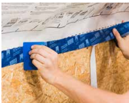
...соединений с конструкционными плитами,
