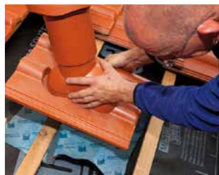
Соединение с вентиляционной трубой.
