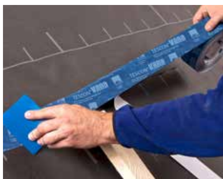
...и нахлестов ветровлагозащитных мембран снаружи.
