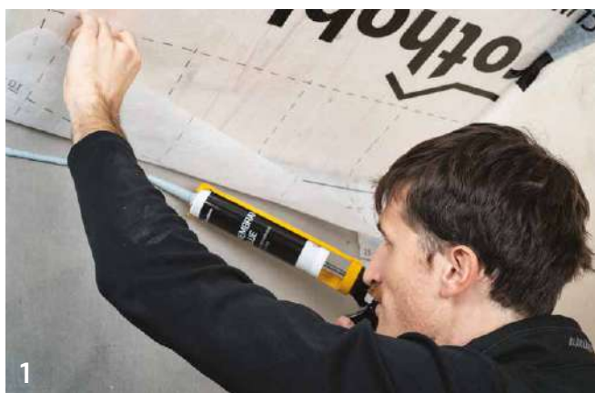
УСТАНОВКА МЕМБРАНЫ НА БЕТОННОЕ ОСНОВАНИЕ
