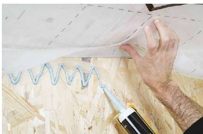
УСТАНОВКА МЕМБРАНЫ НА ОСБ ОСНОВАНИЕ
