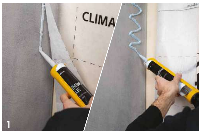
УСТАНОВКА МЕМБРАНЫ НА СТЕНУ - БЕТОН
